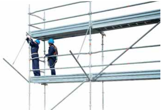
47 • erecting street protection fan
