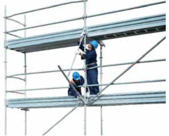
46 • erecting street protection fan
