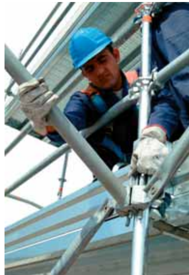
48 • erecting street protection fan
