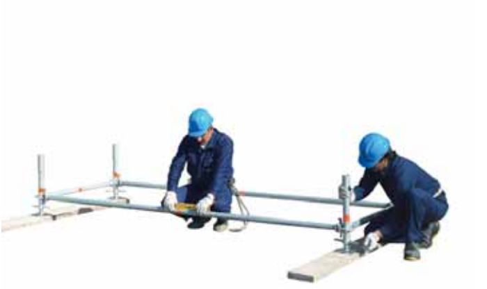
7 • levelling the longitudinal
