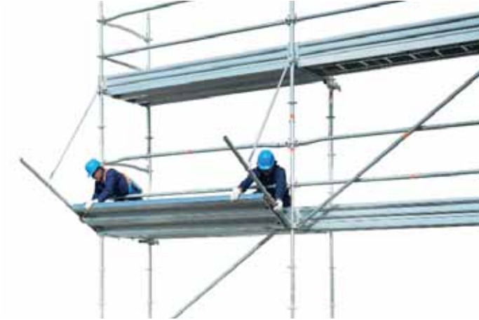
49 • erecting street protection fan
