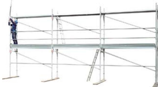
48 • montáž vrcholového stojanu na podlaží 2
