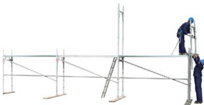
28 • montáž rámu podlažia 1
