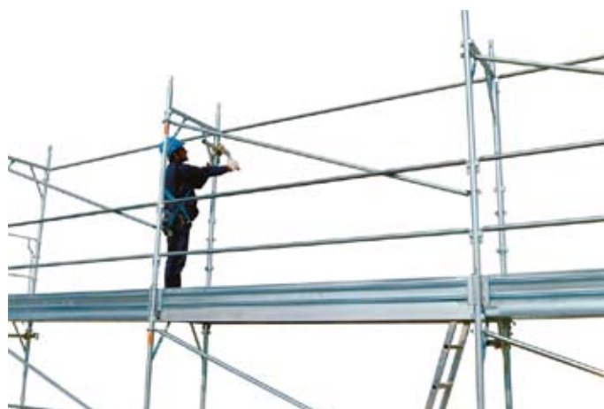
42 • montáž ukotvenia na podlaží 1 podľa požiadaviek
