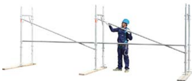
12 • montáž ďalších modulov
