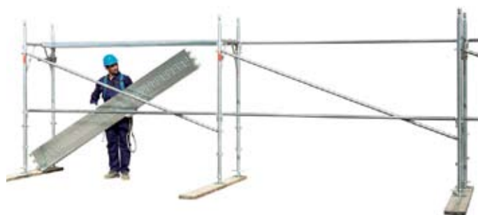
17 • montáž kovových dosiek
