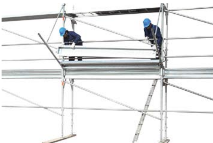
57 • montáž dosiek “protikamenových“ zábran
