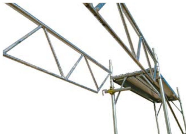
66 • montáž "prejazdového" nosníka
