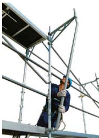
60 • montáž vzpery konzoly
