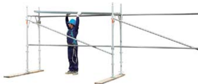
16 • montáž kovových dosiek
