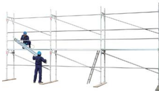
36 • montáž zábran na podlaží 1
