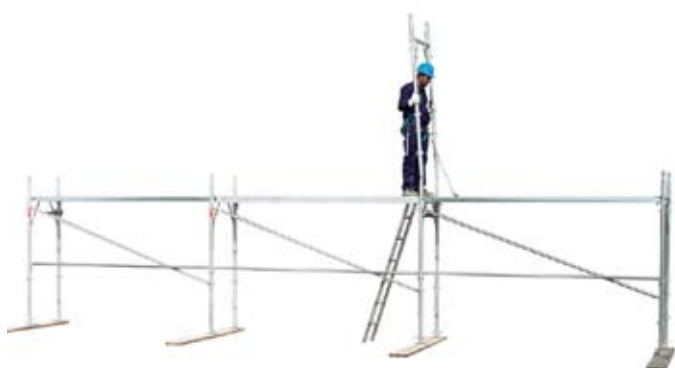
27 • montáž rámu podlažia 1
