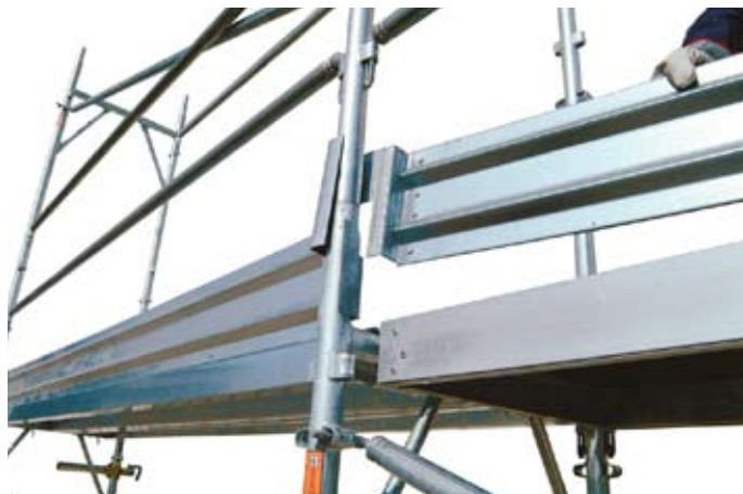
37 • detail zábran na podlaží 1
