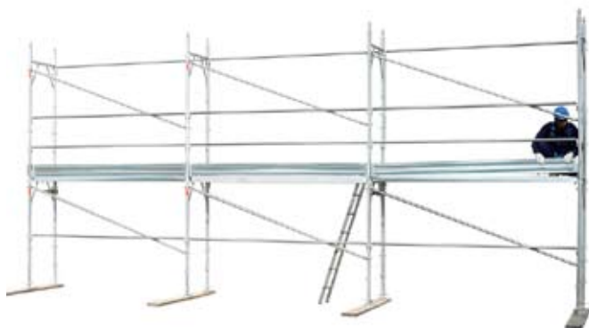
39 • montáž zábran na podlaží 1
