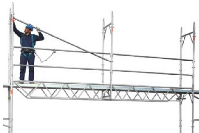
70 • montáž predných priecok nad "prejazdovými" nosníkmi
