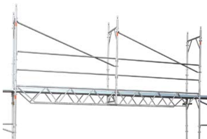
71 • ukončená montáž nad "prejazdovými" nosníkmi
