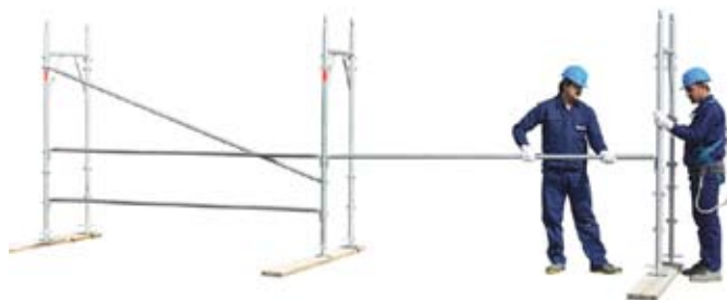
11 • montáž ďalších modulov
