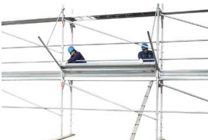
56 • montáž dosiek “protikamenových“ zábran
