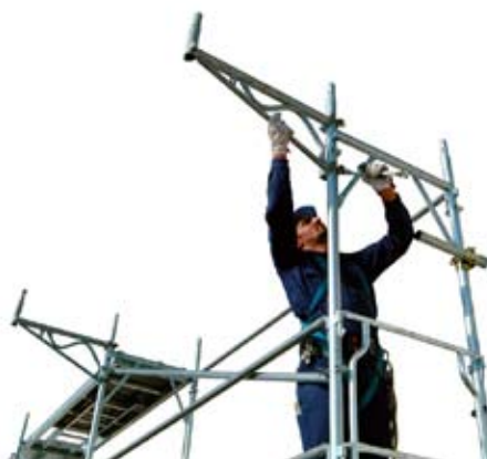
59 • montáž konzoly so vzperou
