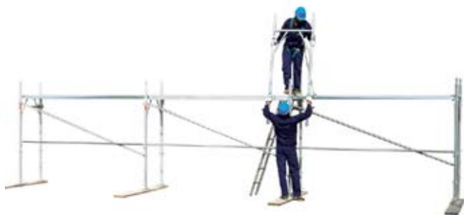
26 • zaciatok montáže rámov podlažia 1
