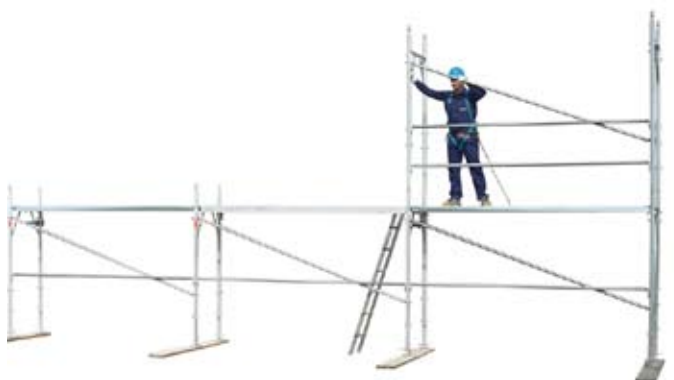
33 • montáž prednej priečky na podlaží 1
