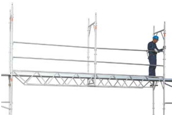
69 • montáž rámov a pozdĺžnych tyčí nad "prejazdovými" nosníkmi
