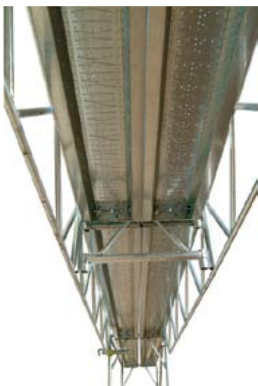
68 • montáž debnenia pod "prejazdovými" nosníkmi
