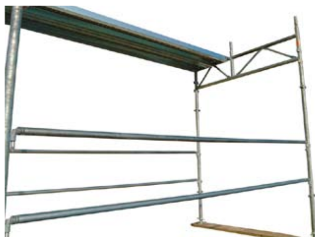
65 • montáž dosiek na rám prechodu pre chodcov
