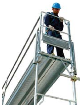
52 • montáž celného parapetu podlažia 2
