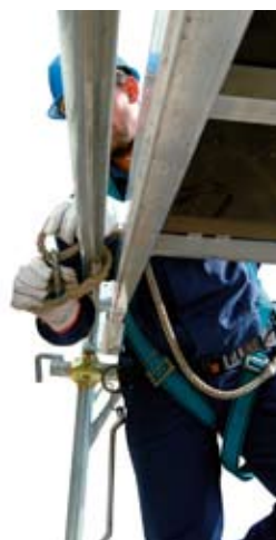
24 • pripojenie prídržného lana pred výstupom na podlažie
