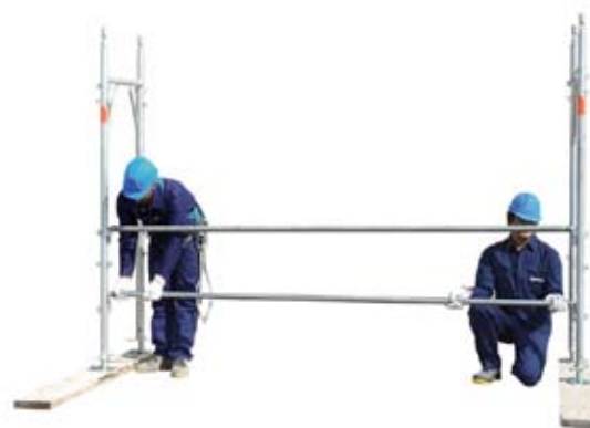
6 • montáž druhej pozdĺžnej tyče
