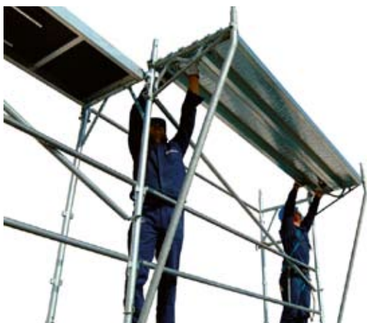
63 • montáž dosiek na konzolu
