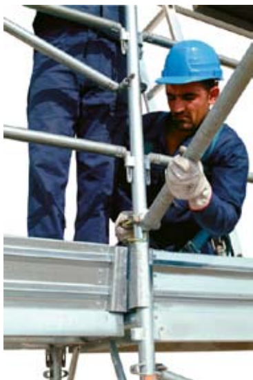
55 • detail protikamenových“ zábran
