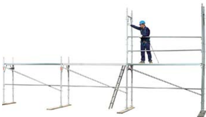
32 • montáž parapety na podlaží 1
