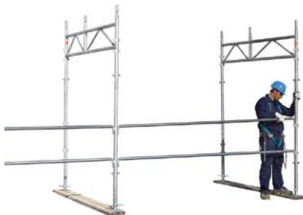
64 • montáž prepojení rámu prechodu pre chodcov
