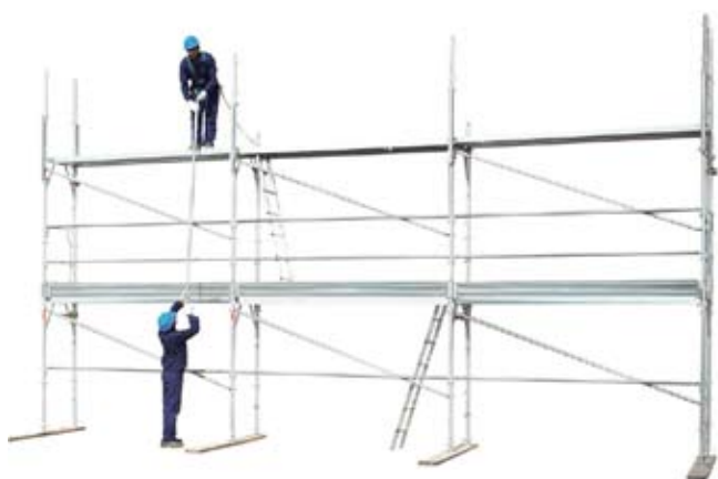
51 • montáž pozdĺžnych tyčí a parapet podlažia 2
