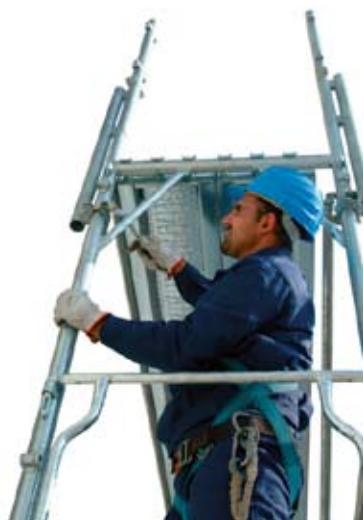
49 • utiahnutie spoja vrcholového stojanu na podlaží 2
