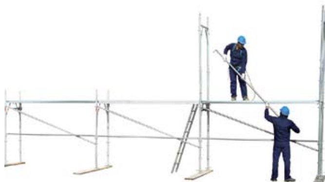
30 • montáž pozdĺžnej tyče podlažia 1
