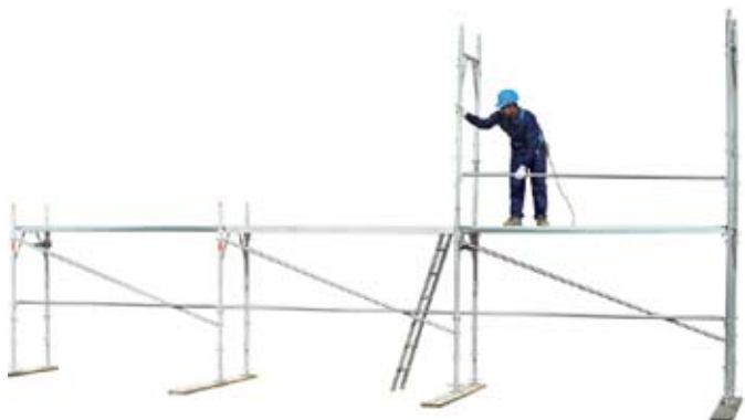
31 • montáž pozdĺžnej tyče na podlaží 1
