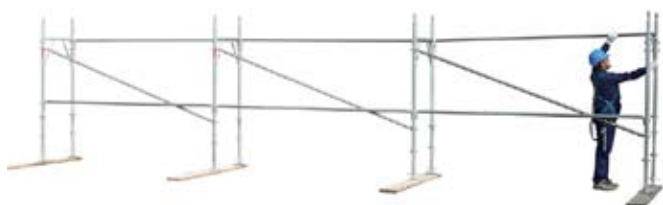
13 • montáž ďalších modulov
