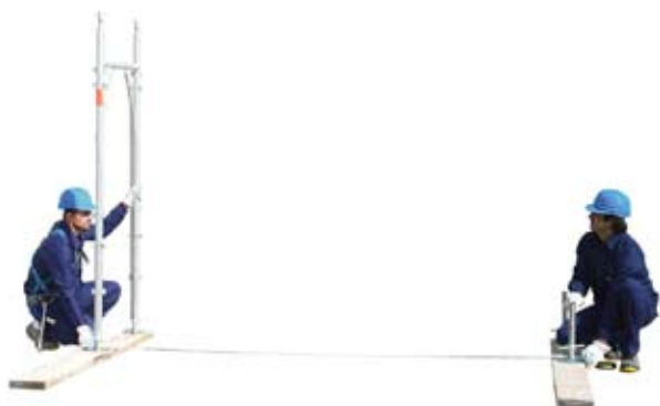
3 • úprava podložiek do vodováhy
