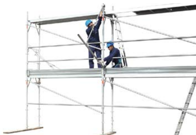
53 • montáž zábran proti padaniu kamenov
