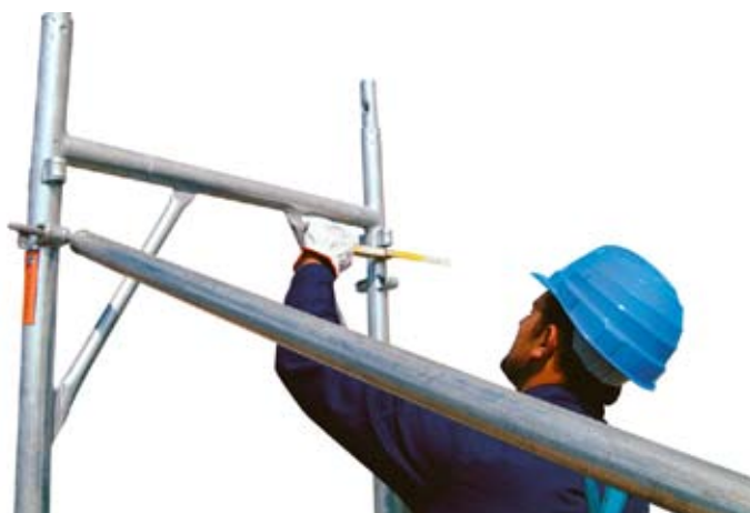
9 • kontrola vzdialenosti od fasády
