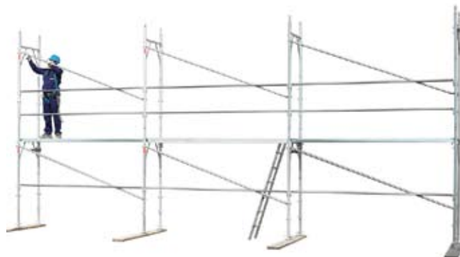
34 • montáž ďalších modulov na podlaží 1
