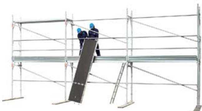
45 • montáž dosiek s prielezom na podlaží 2
