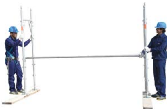
5 • montáž druhého rámu s parapetom
