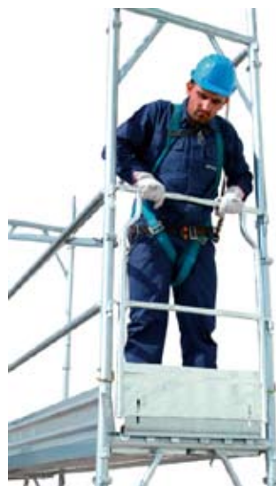
41 • montáž celného parapetu na podlaží 1
