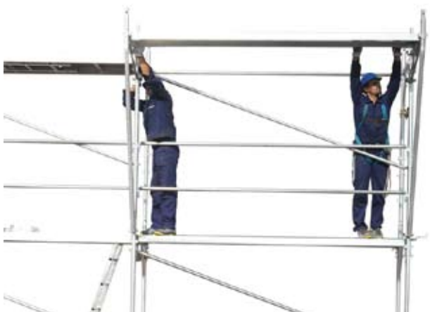
62 • montáž dosiek na konzolu
