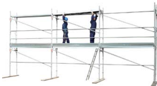
46 • montáž dosiek s prielezom na podlaží 2
