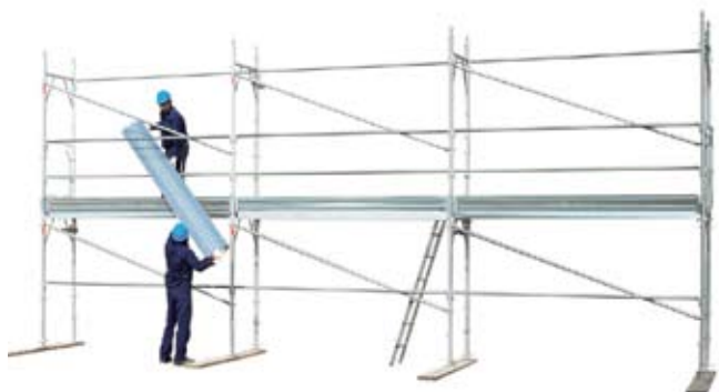
43 • montáž dosiek na podlaží 2
