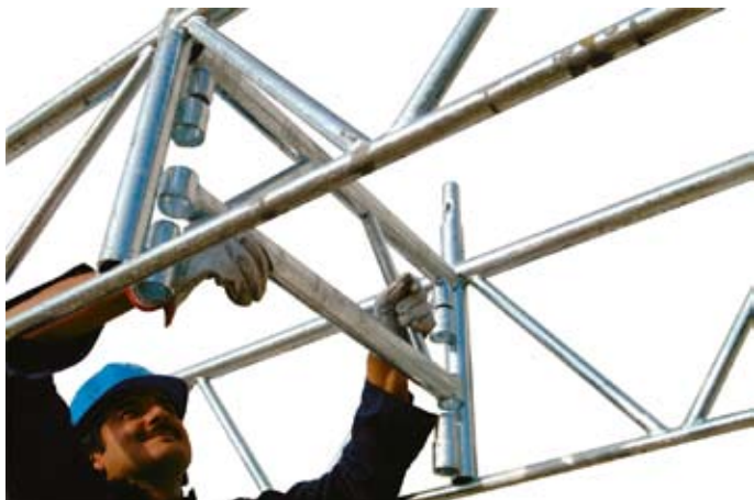
67 • montáž spojovacieho trámu "prejazdových" nosníkov
